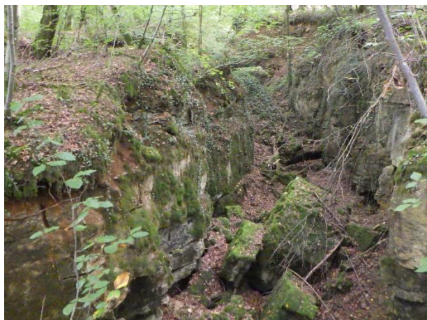
Effondrement dû à l'ancienne activité minière
