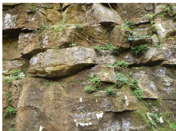
Vue rapprochée d'une paroi de l'ancienne carrière
